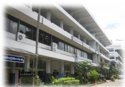
อาคาร 3 อาคารลีลาวดี
