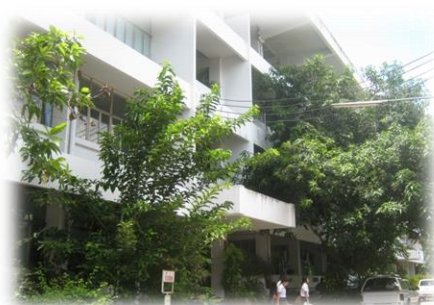
อาคาร 4 อาคารอัมพวัน
